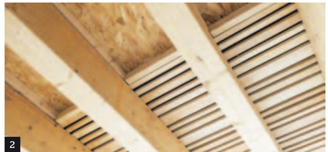
1 et 3 - Les caissons en bois arrivent recouverts d'un film polyane. 2 - Dans les futures salles de réunion, les sous-faces des planchers sont livrées avec leur voligeage en peuplier.
