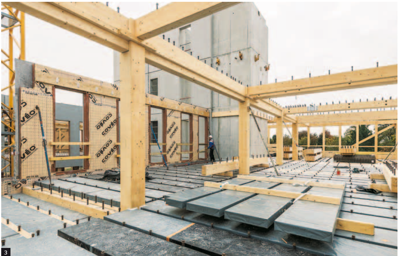
1 et 3 - Les caissons en bois arrivent recouverts d'un film polyane. 2 - Dans les futures salles de réunion, les sous-faces des planchers sont livrées avec leur voligeage en peuplier.
